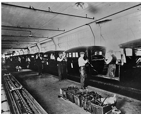
Abbildung 16: Fahrzeugendmontage im Werk Highland Park (ca. 1914)
