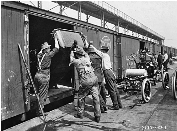
Abbildung 17: Beladung eines Eisenbahnwaggons mit Modell-T-Teilen im Werk Highland Park (1915)
