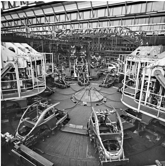
Abbildung 43: Hinterwagen-Karussell im Karosseriebau Werk Wolfsburg (1962)
