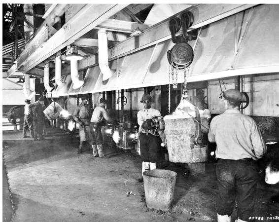
Abbildung 24: Gießerei-Arbeiter im Werk River Rouge (1933)
