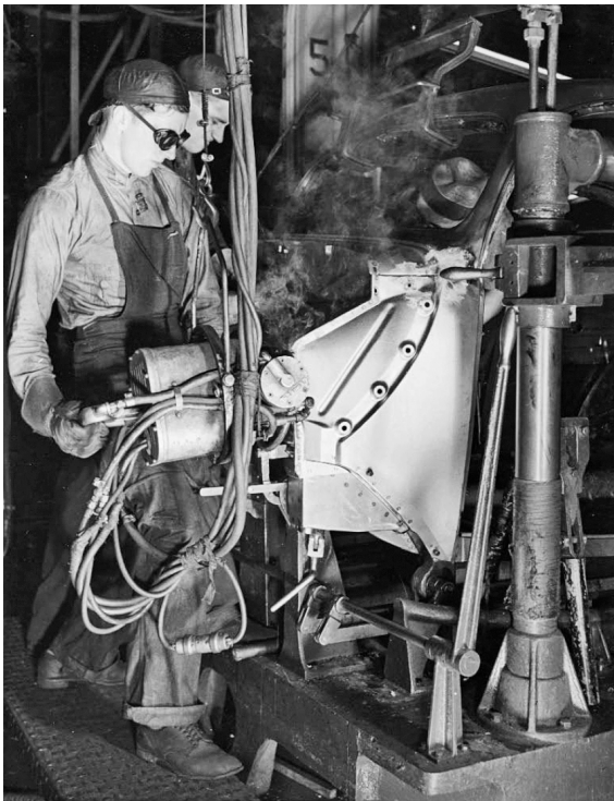
Abbildung 30: Nahtschweißer im Karosseriebau des Werks River Rouge (1936)
