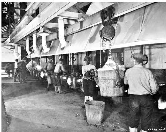
Abbildung 24: Gießerei-Arbeiter im Werk River Rouge (1933)
