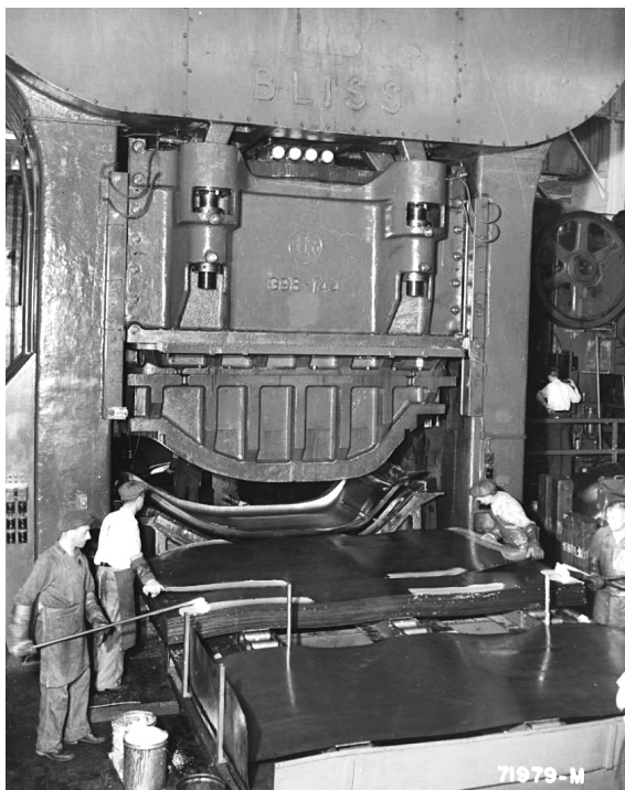
Abbildung 27: Pressen des Dachteils (1939)
