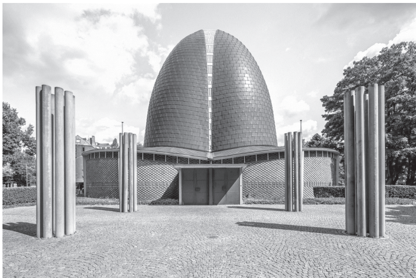
Abbildung 6: St. Rochus in Düsseldorf ist ein einzigartiger sakraler Zentralbau mit einer dreiteiligen, 28 Meter hohen Kuppel. (Foto: GraphyArchy)
