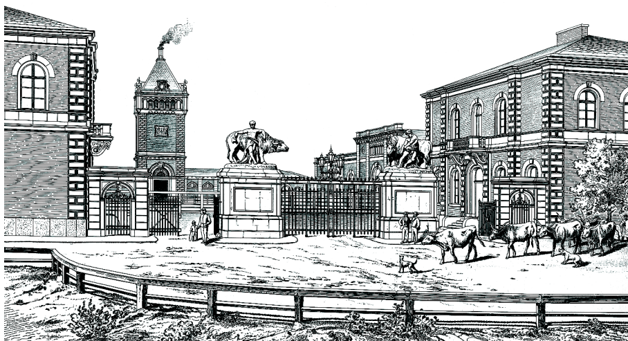
Abb. 1: Hauptportal des Budapester Schlacht- und Viehhofs. Im Hintergrund links der Wasserturm. (Quelle: Hennicke, Julius u. von der Hude: Öffentliches Schlachthaus und Viehmarkt in Buda-Pest, in: Zeitschrift für Bauwesen XXV, 1875, Atlas, Bl. 51)
